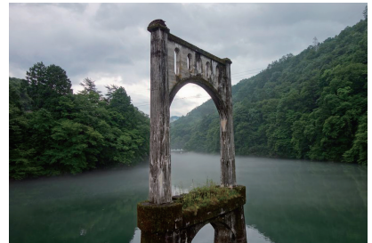
牧尾ダムと吊り橋跡 (撮影: 古澤礼太)
